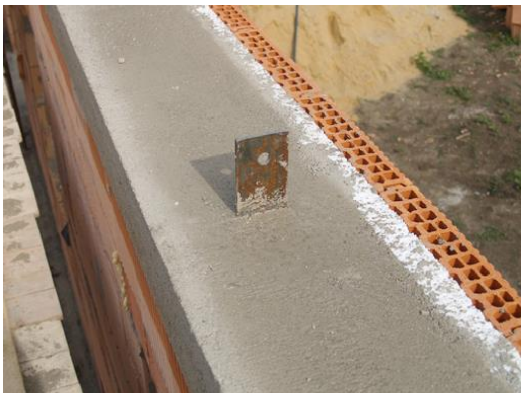
Obr. č. 4 Detail zateplení vnější části zdi polystyrenem
