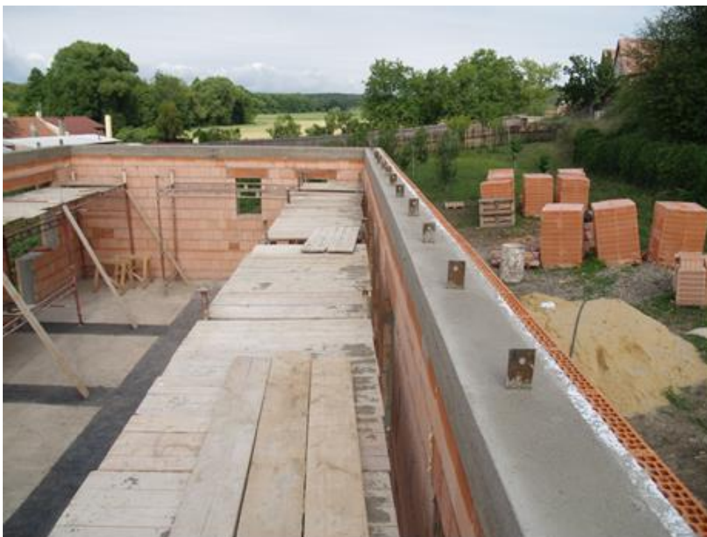
Obr. č. 3 Zabetonovaný věnec s ocelovými úchyty na přišroubování vazníků
